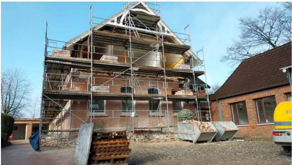
Der Rückbau am Pfarrhaus hat begonnen.
