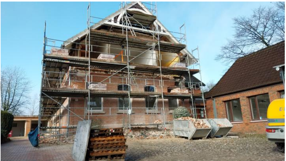
Der Rückbau am Pfarrhaus hat begonnen.
